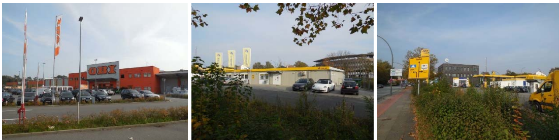
Standortbereich Sander Damm, Aufnahmen: GMA 2017
